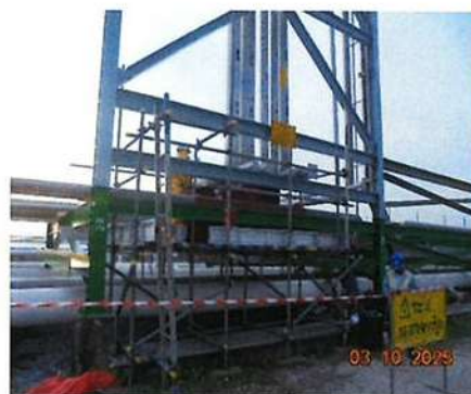
ภาพที่ 2-54 ราวเหล็กโดยรอบพื้นที่ปฏิบัติงาน
