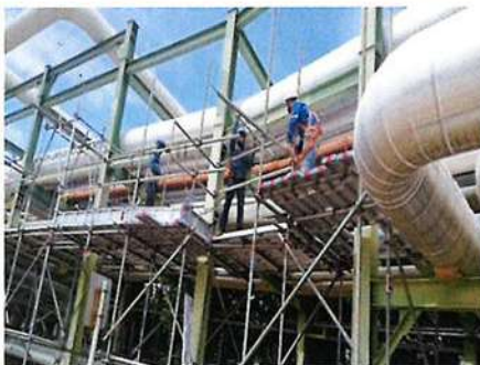
ภาพที่ 2-46 มาตรการด้านความปลอดภัยสำหรับการทำงานในที่สูง
