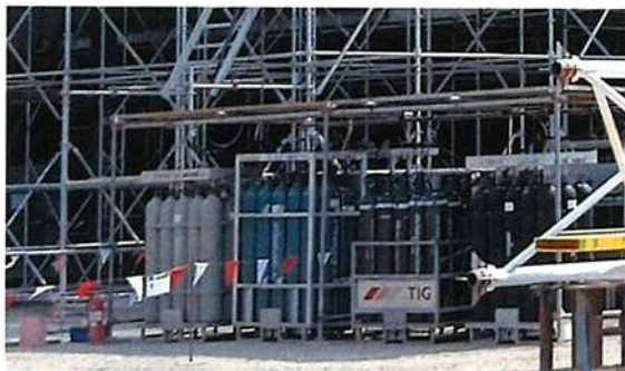
ภาพที่ 2-50 พื้นที่สำหรับจัดวางถังแก๊ส
