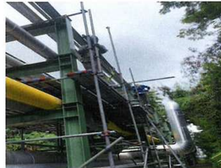
ภาพที่ 2-47 การติดตั้งนั่งร้านสำหรับการปฏิบัติงานในพื้นที่สูง
