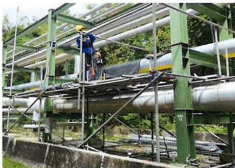
ภาพที่ 2-47 การติดตั้งนั่งร้านสำหรับการปฏิบัติงานในพื้นที่สูง
