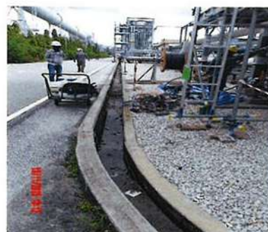
ภาพที่ 2-22 รางระบายน้ำโดยรอบพื้นที่โครงการ
