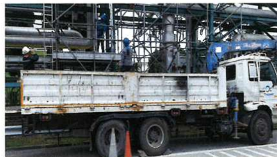
ภาพที่ 2-59 การดับเครื่องยนต์ และมีหมอนรองที่ล้อรถ
